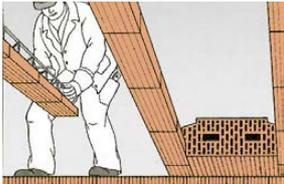
Für die Verlegung der Lücking Ziegelrippendecke ist bei den geringen Träger- und Ziegelgewichten in der Regel kein Hebezeug erforderlich, sondern die Verlegung kann von Hand erfolgen. Unter dem Deckenaufleger ist eine Lage 500er Bitumenpappe einzulegen. Die Träger sind mindestens 12 cm aufzuliegen.
