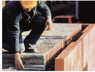
Die Mindestauflagertiefe auf Mauerwerk oder Stahlbeton beträgt 5 cm im Montagezustand. Randjoche sind im Bereich von Rollladenkästen, Stürzen und Unterzügen erforderlich, wo kein Auflager von 5 cm für den Montagezustand vorhanden ist.
