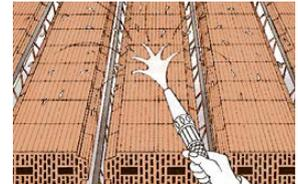
Vor Einbringen des Vergussbetons C25/30 (Beton mit weicher Konsistenz verwenden), sind die Deckenziegel vorzunässen. Für Nachbehandlung und Ausschalfristen ist die DIN EN 206 / DIN 1045 zu beachten. Vor dem Aufmauern der Wände des folgenden Geschosses ist unter der ersten Ziegellage ein Streifen Bitumenpappe einzulegen.
