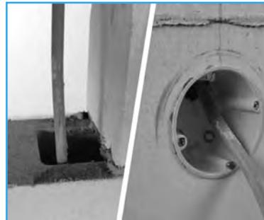
Die Steinöffnungen können hervorragend als Kabelleitungen genutzt werden.
