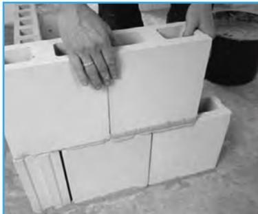
Zur besseren Stabilität und zur optimalen Ausnutzung der Stehöffnungen sollte als Überbindemaß 1/2 Stein gewählt werden.
