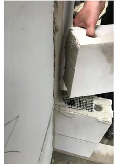
Die Bildreihe zeigt das Konstruktionsprinzip und die Verarbeitung der **BMO FlexVerbinder**.
