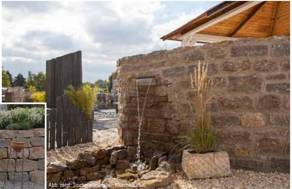
Abb. zeigt: Trockenmauerstein Muschelkalk
