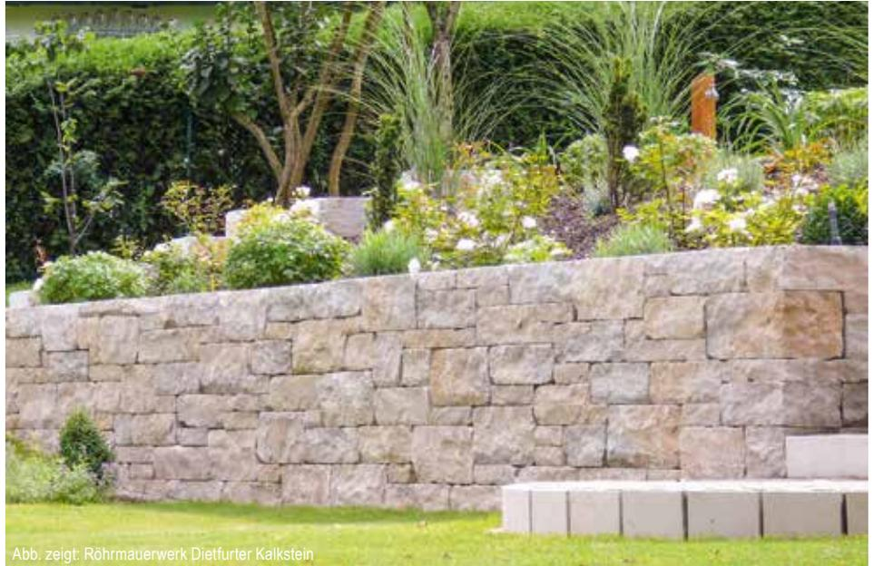
Abb. zeigt: Röhrmauerwerk Dietfurter Kalkstein
