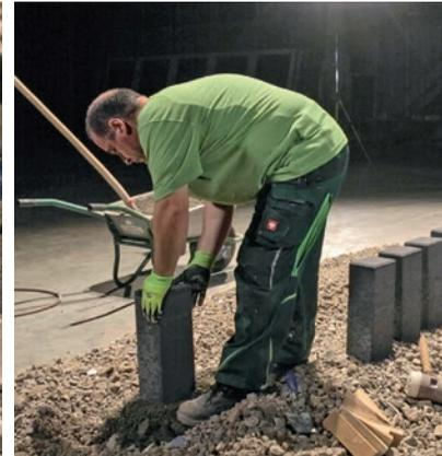
Hergestellt werden die Palisaden aus Qualitätsbeton in eigens entwickelten Spezialmaschinen. Hierbei entsteht eine naturraue Oberfläche ("Elefantenhaut"), welche besonders robust und schmutzresistent ist. Da alle Elemente nach gleichem Verfahren angefertigt werden, lassen sie sich gut miteinander kombinieren. Materialbedingte, technisch nicht vermeidbare Struktur- und Farbschwankungen sind zwar möglich, technisch aber nicht vermeidbar.
