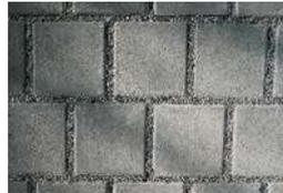
Mit Rima® kann Niederschlagswasser zuverlässig in den Untergrund versickern. Sowohl die breite Rasenfuge als auch die schmale Drainfuge fügen sich harmonisch in jedes häusliche Umfeld ein. Der quadratische Stein befestigt jede Fläche sicher, ohne den Boden zu versiegeln.
