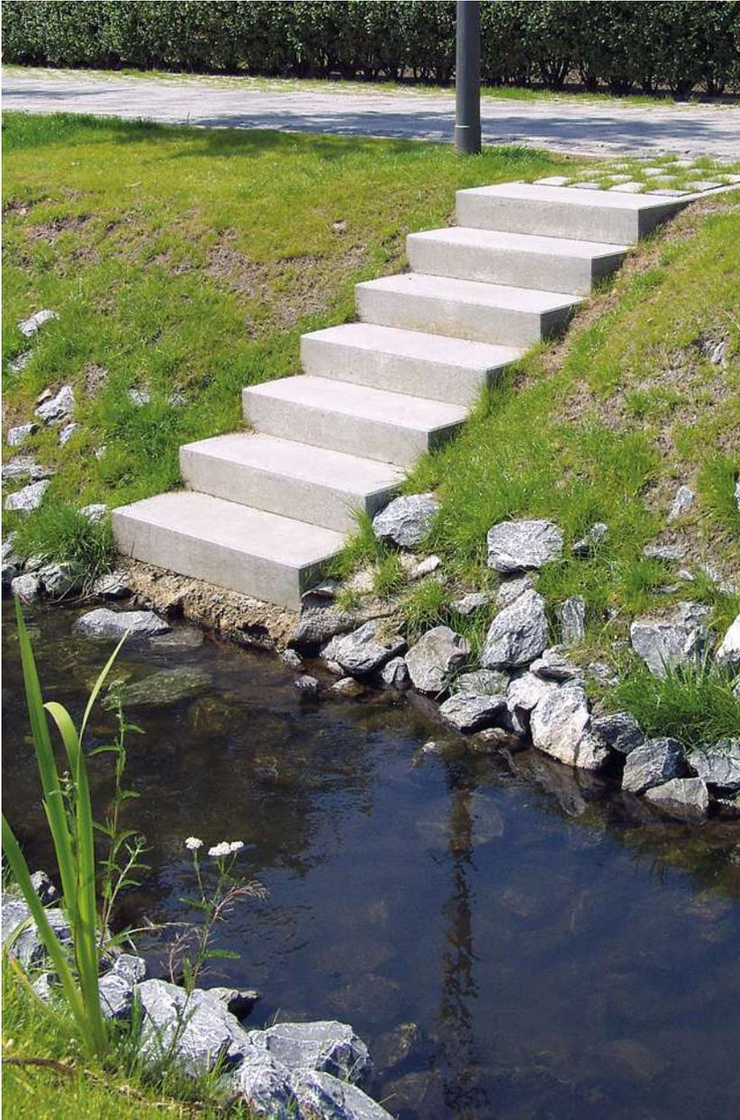
Die preiswerte Variante: eine Stufengröße, eine Farbe. Wenn Design hinter der Funktionalität zurückstehen kann, sind Böschungsstufen eine gute Alternative für den Bau von Treppen im Garten- und Landschaftsbereich.
