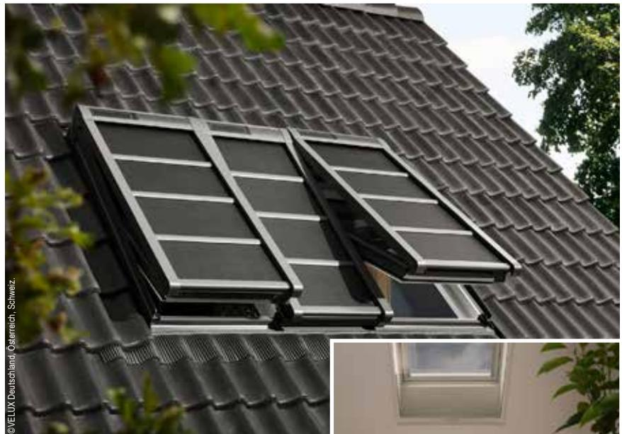
Markisetten, hier in der verdunkelnden Ausführung, werden außen auf dem Fensterflügel montiert und verhindern so, dass die energiereichen Sonnenstrahlen auf die Scheibe treffen.
