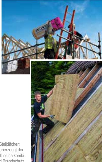
Besonders verarbeitungsfreundlich wird der ULTIMATE ZKF-031 dank seiner zuverlässigen Klemmwirkung von bis zu 1.200 mm und seiner hohen Druckfestigkeit. Gleichzeitig weist die ULTIMATE Lösung – im Vergleich zu herkömmlichen Steinwollsystemen – ein geringeres Flächengewicht auf, was nicht nur die statischen Planungen erleichtert: Die Klemmfalze werden in hoch komprimierten Verpackungen angeliefert, wodurch auch weniger Lagerplatz benötigt und das Handling um ein Weiteres vereinfacht wird.
