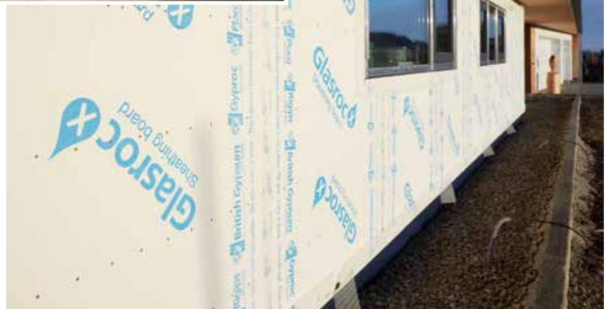
Rundum geschützte Fassaden: Die anorganische und mit einem äußerst UV-Licht-beständigen Glasvlies ausgestattete Oberfläche der Rigips Glasroc X ermöglicht eine temporäre, direkte Bewitterung, sodass Außenwände über mehrere Monate hinweg vor Witterungseinflüssen geschützt bleiben. Gleichzeitig ist die Plattenoberfläche für die Aufnahme von Putzsystemen optimiert, welche die Funktion des permanenten Wetterschutzes übernehmen.
