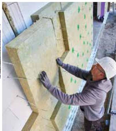
Die neue Kernrock 033 Dämmplatte wird in bewährter Weise im Verband verlegt und so auf die Mauerwerksanker aufgebracht, dass sie dicht gestoßen ohne Fuge an der Wand und an der nächsten Platte anliegen.
