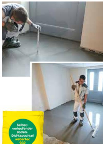
Mit dem selbstverlaufendem Bodendichtspachtel weber.tec 932 können Fachhandwerker Kellerböden gleichzeitig abdichten und egalisieren.
