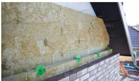
Beispiel Außenwandkonstruktion für ein KfW 40 Haus: Innen eine hoch tragfähige und stoßfeste Wand aus Porenbeton, außen witterungsbeständiger Verblendklinker in einer Dicke von 11,5 cm und dazwischen zwei Lagen der neuen Kernrock 033 Steinwolle-Dämmplatte.
