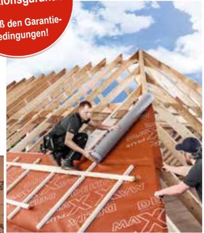
Dank patentierter Klebestreifenanordnung kann die Bahn beim Verlegen einfach gedreht werden.
