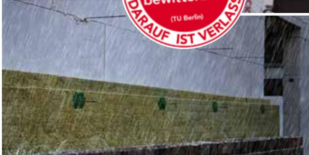
Sicherheit auch bei Bauverzug. Die TU Berlin hat es durch einen Test bestätigt: Selbst bei drei Monaten freier Bewitterung werden die maßgeblichen Eigenschaften der Kerndämmung nicht beeinträchtigt. Regenwasser dringt nicht in den Dämmstoffquerschnitt ein und auch Nebelnässe wird nicht vom Dämmstoff aufgesogen.
